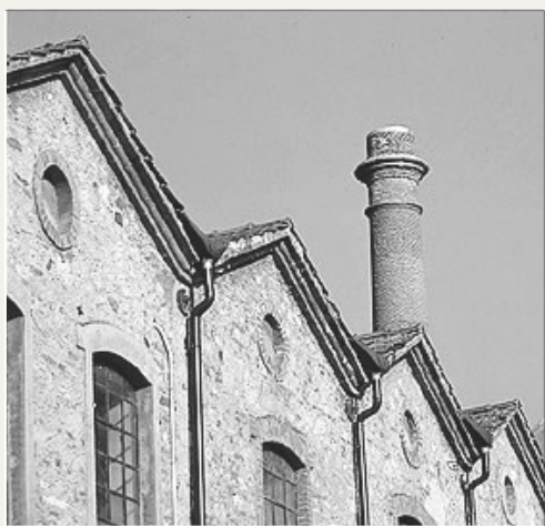
"A ricordo storico sentimentale dell'epoca d'impianto", come romanticamente descrive lo stesso progettista, è stato eseguito anche il restauro conservativo della vecchia ciminiera posta sul lato nord del complesso.
